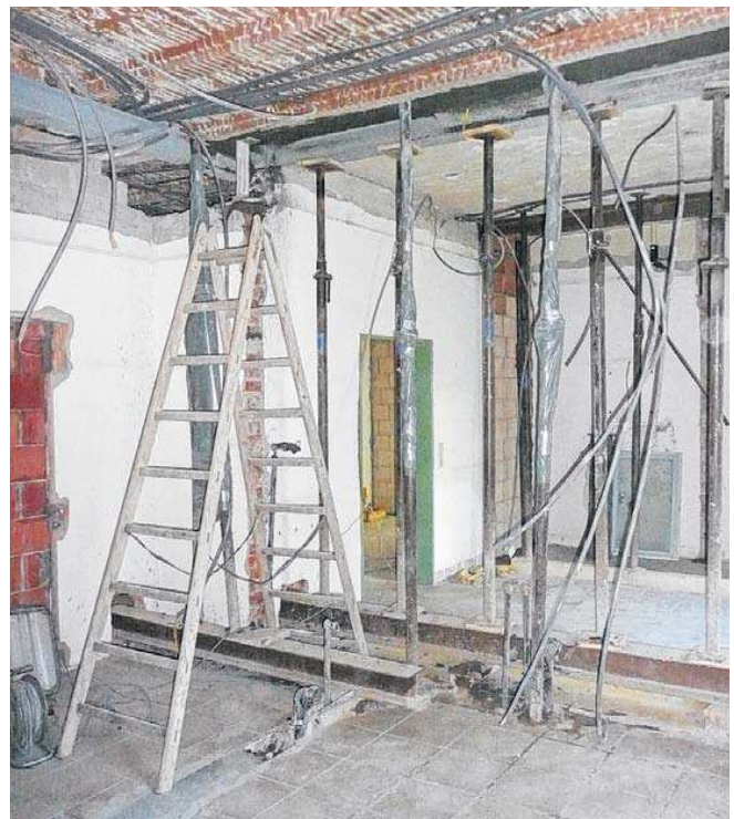
Statische Baumassnahmen für Konferenzraum 2012
